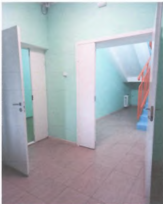
Фото № 15 – Внутренние двери на 2-й этаж
