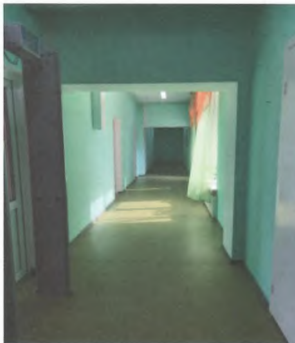
Фото № 10 – Коридор от входной двери налево
