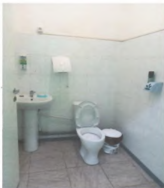
Фото № 13 – Служебный санузел (главный коридор)
