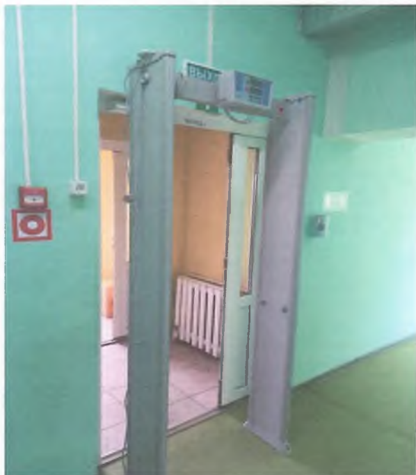
Фото № 7 – Внутренняя входная дверь
