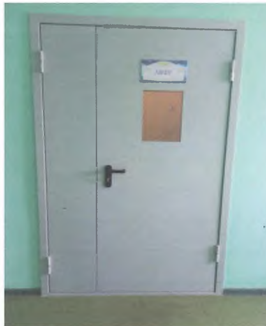
Фото № 24 – Лифт на 2 – й этаж
