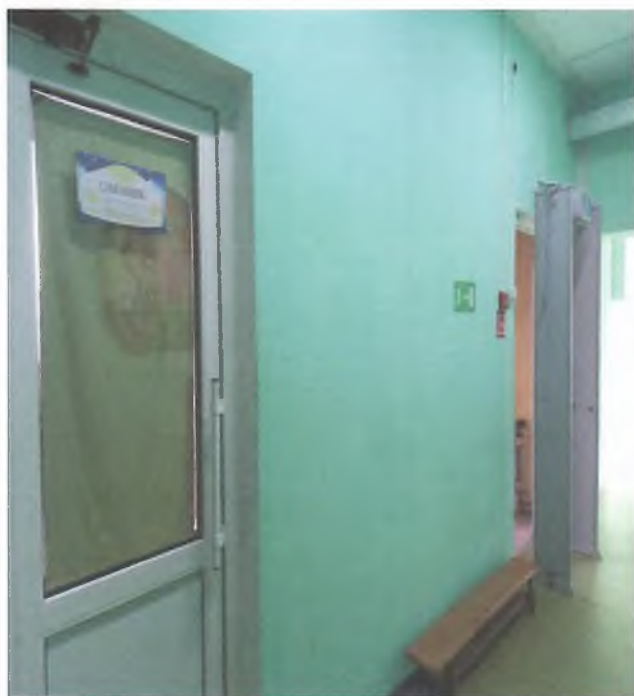
Фото № 9 – Дверь охраны, от входной двери направо
