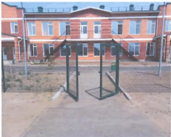
Фото № 1 - Вход на прилегающую территорию
