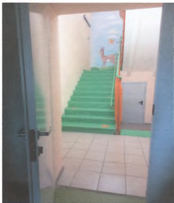
Фото № 19 – Лестница (4) на 2 – й этаж
